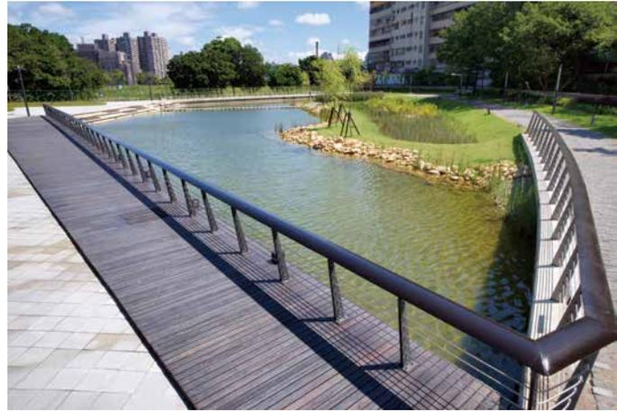
為了符合 LEED 認證評估項目的要求，籌建中的 TPKD 商辦大樓規劃了多項環保節能的措施，希望達到永續基地的目標。劉志隆副理舉例，「我們在戶外景觀區大量採用透水鋪面，以增加基地的保水功能，並利用基地西側、北側空地，規劃雨水花園，選用原生、抗旱、誘鳥誘蝶的植栽，以多樣性及複層種植手法，創造豐富的景觀生態花園，平時可供休憩觀賞，雨天則可蓄集雨水，降低地表逕流，以達城市防災功效。」不僅如此，設計團隊也計畫藉由太陽能光電及屋頂綠化，吸收或反射太陽幅射熱，減緩大樓的熱島效應。「我們在 2F 戶外平臺與屋頂花臺種植草皮、灌木及小型喬木，增加綠覆面積，同時，選用低能耗、照明範圍向下的 LED 燈具，滿足夜間安全亮度的需求，並且減少對夜行動物的干擾。」
